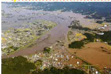
令和元年東日本台風で中小河川(内川・新川)が決壊し、浸水するようす 出典: 国土地理院ウェブサイト ( https://www.gsi.go.jp )
