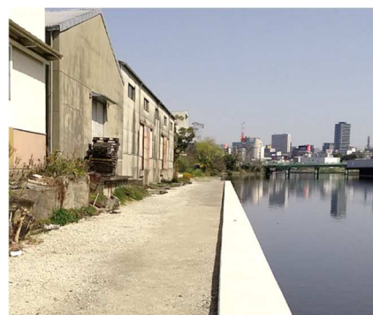
前出し護岸による護岸改良
