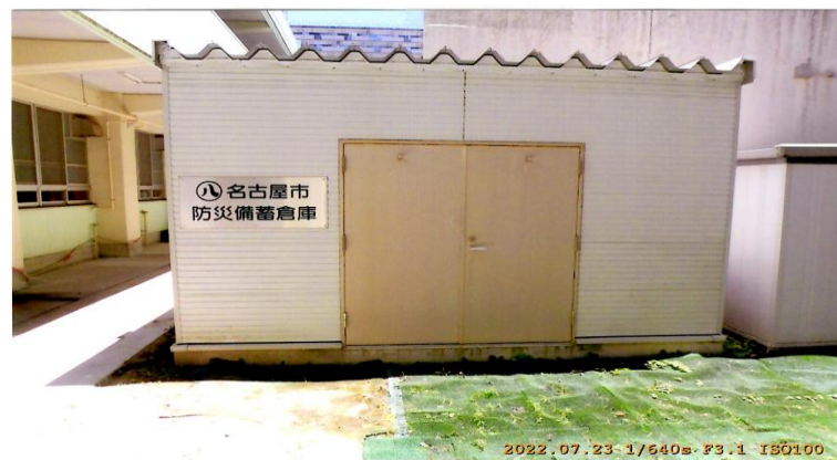
中校舎北側中庭1階防災備蓄倉庫
