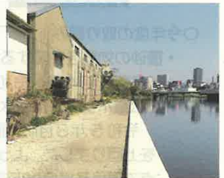
前出し護岸による護岸改良
