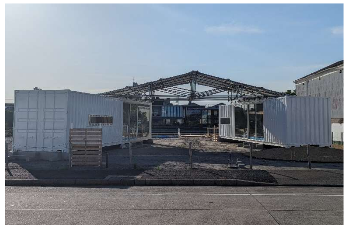
令和6年5月10日時点(工事中)
