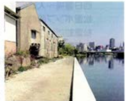
前出し護岸による護岸改良
