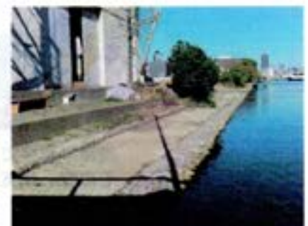
石積みによる護岸補修
